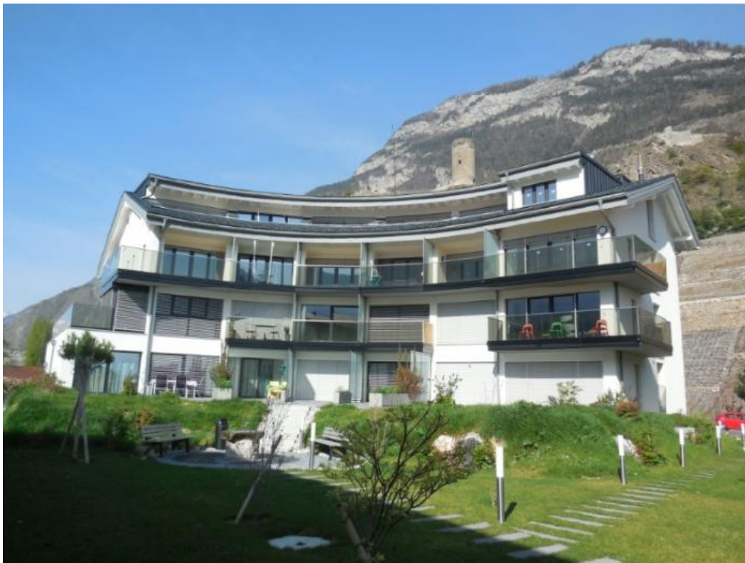
Vue bâtiment du jardin
